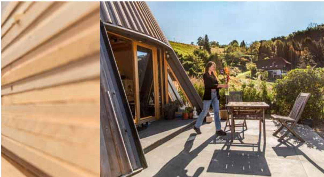
Von einem Blatt Papier bis zu den Blumen auf der Tipi-Terrasse: Steht der Konstruktionsplan, geht's ans Bretterschneiden. Die werden vom Stapel zur Bandsäge gebracht, um sie in Form zu bringen. Am Ende schmiegt sich das kegelförmige Holzgebäude der Junkers in die dichtbewaldete Hügellandschaft
